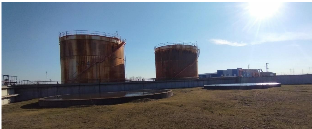
Слика бр.10: Постојећи темељи на којима се планира изградња резервоара са танкванама
